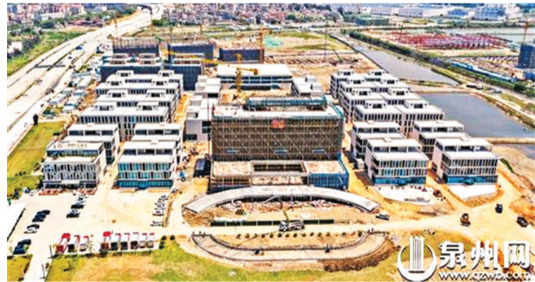
中信重工智慧产业园建设现场
