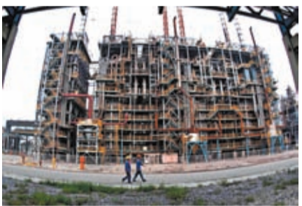
天津石化公司烯烴部乙烴裂解爐增加空氣預熱器改造工程全部投入運行，年節約燃料氣量1,820噸。 資料圖片
