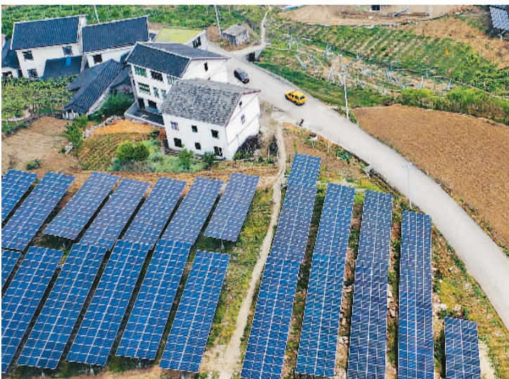
南方电网贵阳供电局积极探索新型电力系统建设，优化调整电网运行方式，为经济社会发展提供绿色动能。目前，贵阳电网新能源总装机容量达327.59兆瓦，实现清洁能源100%消纳。图为位于贵州省贵阳市息烽县的大型综合能源项目——中核贵州息烽县小寨坝100兆瓦光伏发电场。李波摄(人民视觉)
