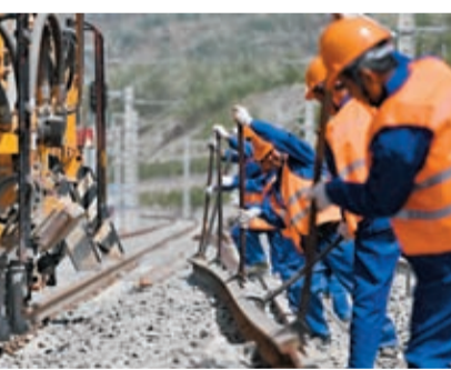
◆ 工作人員在重載鐵路線進行施工作業。 資料圖片
