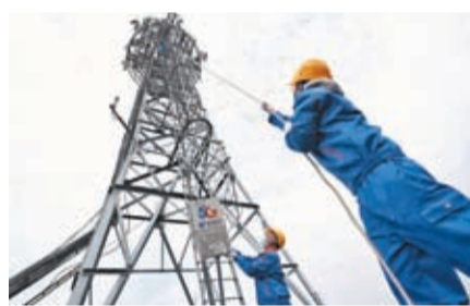
◆ 《實施意見》鼓勵跨行業開放共享，推進「一杆多用」「一塔多用」。圖為中國電信施工人員正在進行5G基站的安裝。 資料圖片
