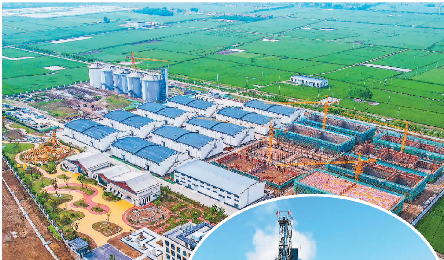
▲江苏省宿迁市宿豫区粮食产业园集粮食仓储物流、加工贸易、检验检测等为一体，规划建设17栋低温平房仓、10栋低温浅圆仓、粮食加工厂房和烘干中心。全部建成后，仓容量可达20万余吨。图为该粮食产业园建设工地。 陈少帅摄（人民视觉）
