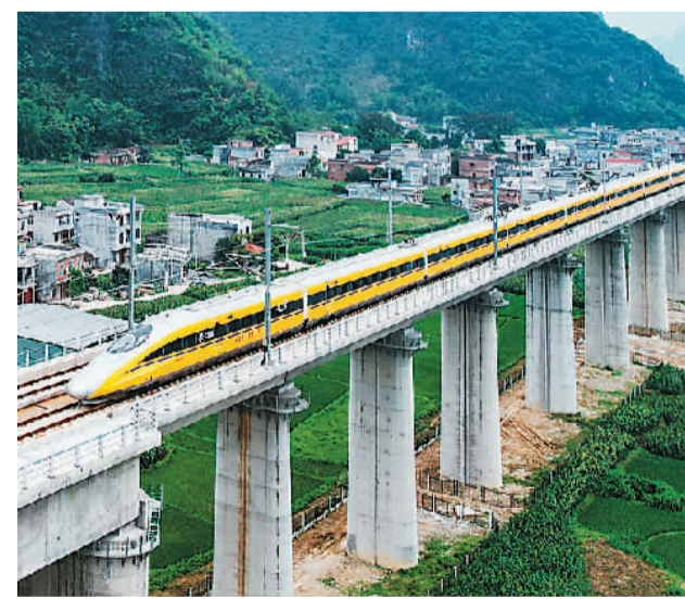
5月16日，高速综合检测列车行驶在贵南高铁上进行检测工作。 新华社记者 张爰林摄
