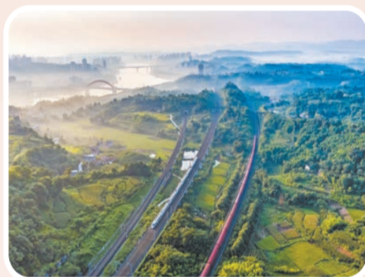
合川加速開放通道建設。
