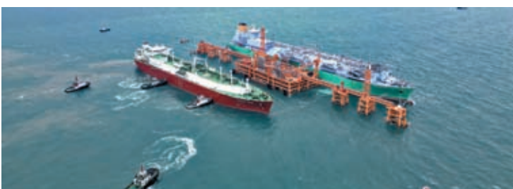
◆香港LNG項目實現首船卸料和管線通氣。網上圖片
