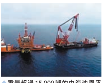
重量超過15,000噸的中海油恩平20-4海上鑽探平台與海底導管架對接成功。
