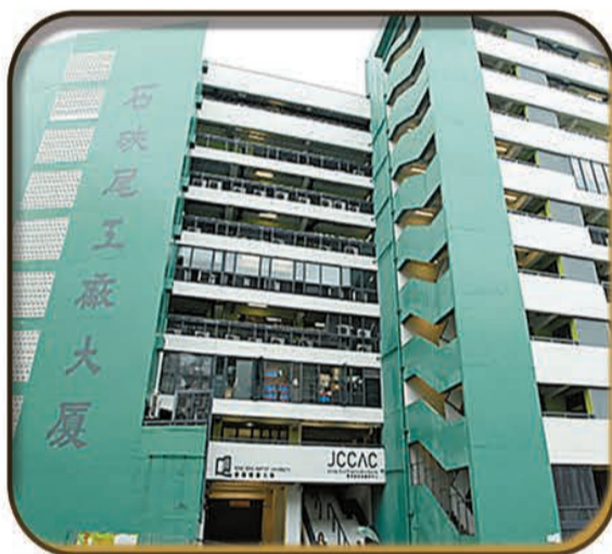
賽馬會創意藝術中心由工廠大廈改建而成，以非牟利模式營運。
