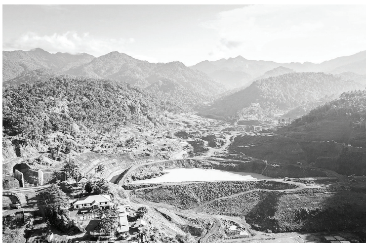
西龙目水库明年中旬可竣工 西努省西龙目县(Lombok Barat)古农沙里镇(Gnung-sari)布吉丁宜乡(Bukit Tinggi)的默宁丁(Meninting)水库建设进展达51.29%,指定目标于2024年6月完工。
