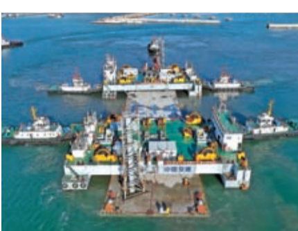
大連灣海隧安裝巨型海底沉管。香港文匯報記者宋偉攝
