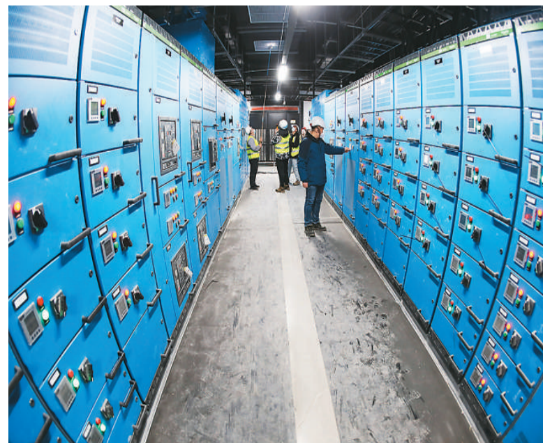
在河北省张家口市的合盈数据(怀来)科技产业园，工人正在进行设备安装调试。武殿森摄(人民图片)
