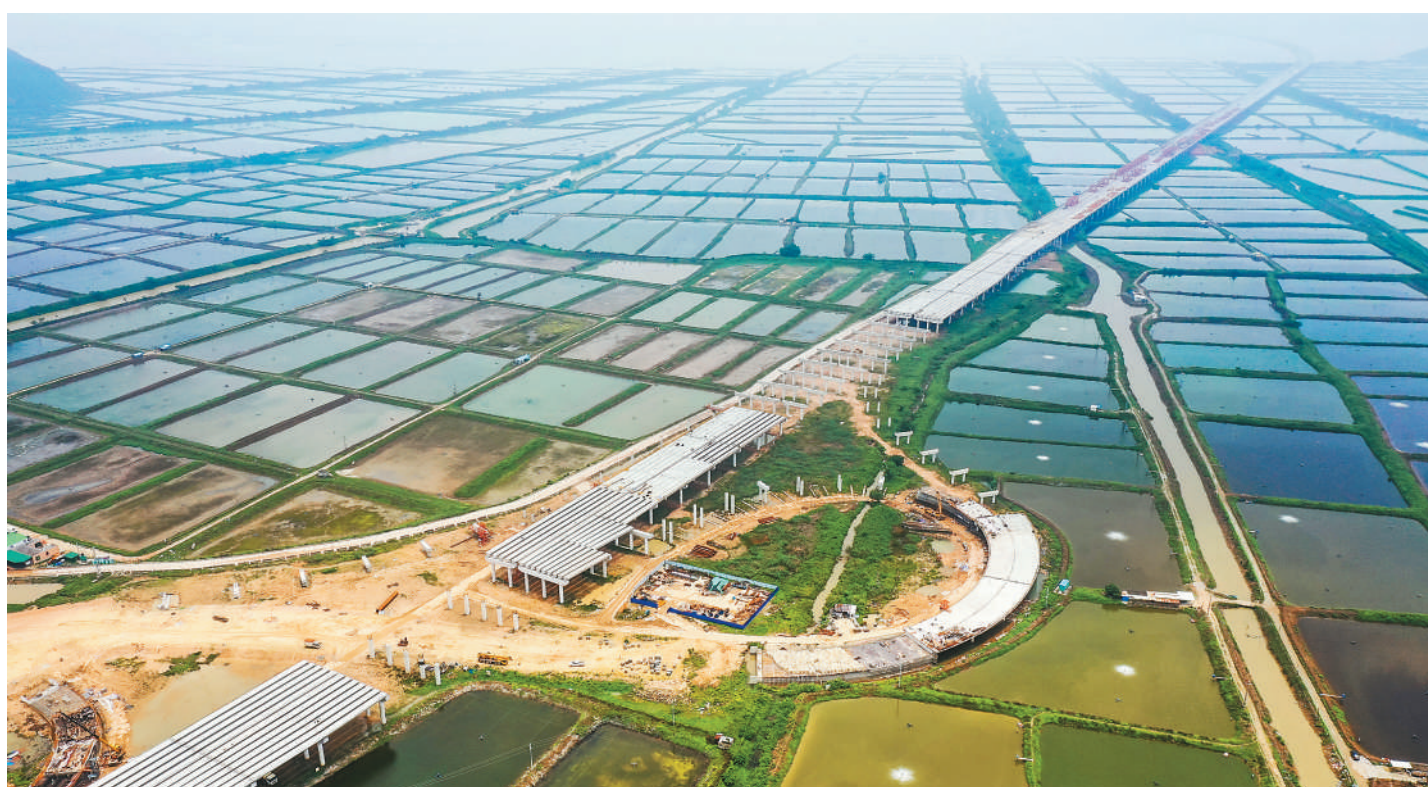
由中铁十一局承建的黄茅海跨海通道建设进展顺利。黄茅海跨海通道起于广东省珠海市高栏经济区，向西跨越珠江口崖门入海口黄茅海水域，终于江门市斗山镇，线路全长约31公里，预计2024年建成通车。图为黄茅海跨海通道崖门山段赤溪互通架梁现场。新华社记者 刘大伟摄
