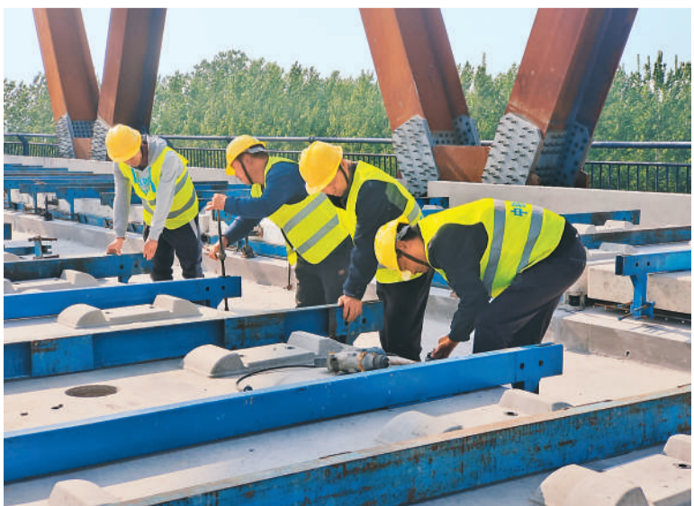
近日，由中铁上海工程局承建的郑济铁路（山东段）项目无砟轨道施工全部完成，为项目后续铺轨工作和通车运营奠定基础。郑济铁路是国家“八纵八横”高铁网的重要连接线，对优化国家铁路网布局、推动山东省中西部地区与中原地区互联互通意义重大。通车后，济南至郑州通行时间将缩短至2小时。图为工人在检查无砟轨道。 武文成摄（人民视觉）
