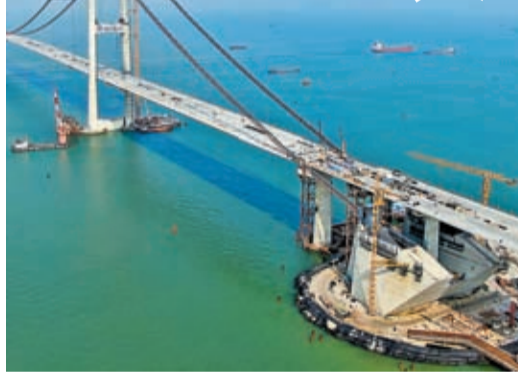
◆4月28日上午，深中通道伶仃洋大橋施工人員在完成最後一片匹配件安裝，標誌着該項目橋樑工程實現全線合龍。新華社
