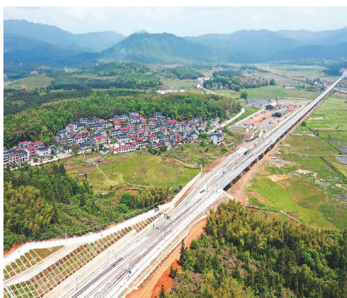
4月26日,昌(南昌)景(景德镇)黄(黄山)高铁全线铺轨贯通。昌景黄高铁建成通车后将连接杭(杭州)黄(黄山)高铁,有利于拉动沿线旅游产业发展。图为江西省景德镇市浮梁县境内建设中的昌景黄高铁。时 雨摄(人民视觉)
