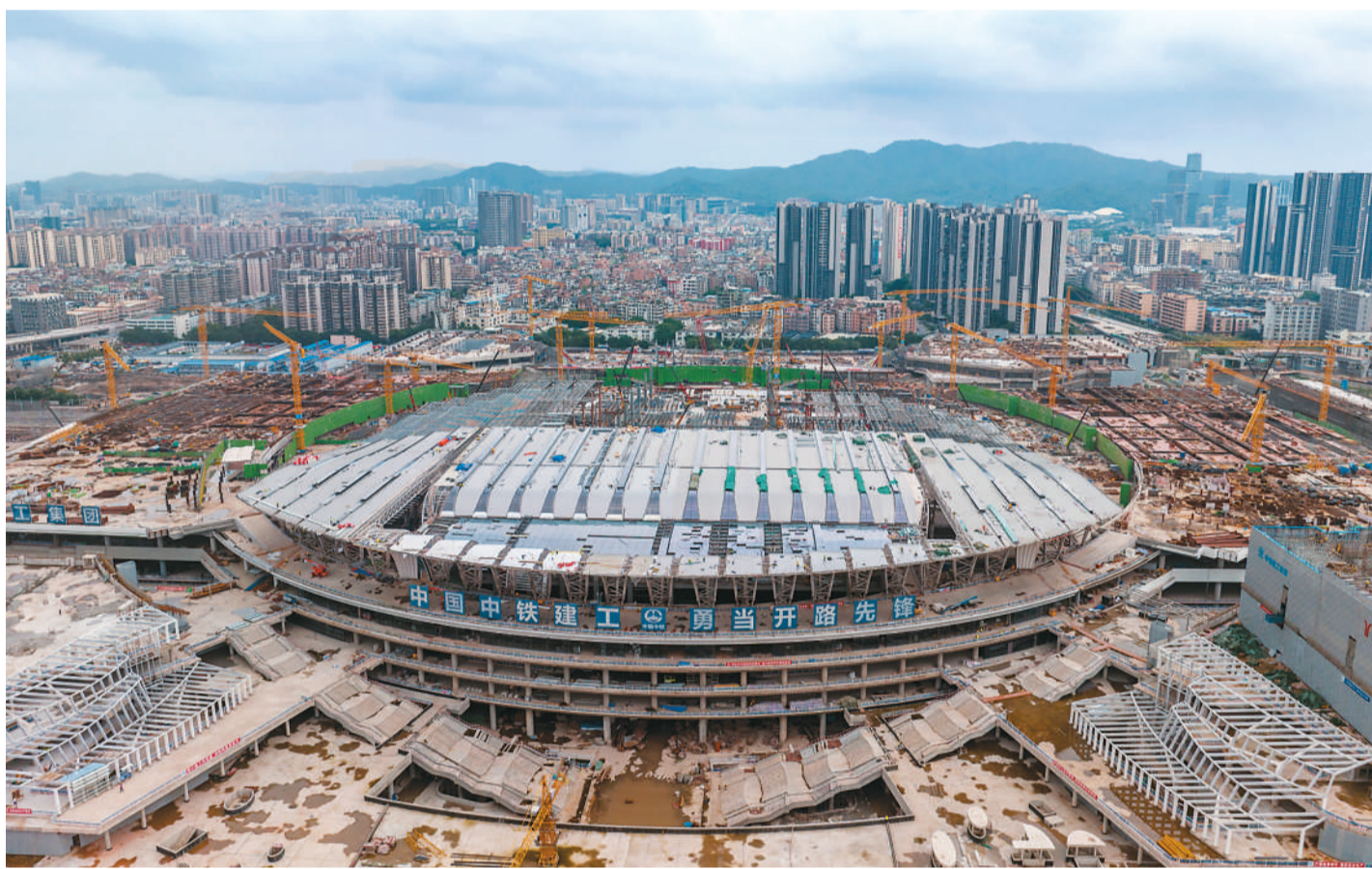
连日来，广东广州白云站各项建设工程稳步推进。据悉，白云站位于广州市白云区，是广州铁路枢纽规划中的主要客站之一，建成后将加速白云区客流导入，助力当地产业发展。
