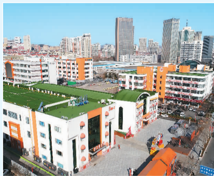
山东自贸试验区青岛片区成立以来,持续对区域内的老厂房、老建筑进行升级改造,在保留老厂房原有风貌的基础上,又导入时尚活力的新产业、新业态,打造融合跨境电商、创新商业、文化展示、科创办公以及工业旅游等要素的智慧型园区,让老厂房重新焕发出勃勃生机。图为由老厂房改建而成的“闯创驿”智慧园区。 张进刚摄(人民视觉)
