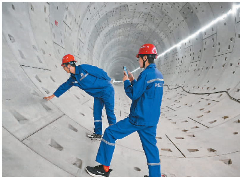
4月14日，四川成都轨道交通18号线三期首个管段盾构区间实现贯通。该项目连接成都市区与天府国际机场，由中国铁建施工总承包，中国铁建昆仑集团、中铁二十二局集团、四川铁科建设监理公司等承建，设计速度140公里每小时，为中国西南地区最快地铁线路。图为技术人员在项目现场检查管片拼装质量。桂天奇摄(人民视觉)
