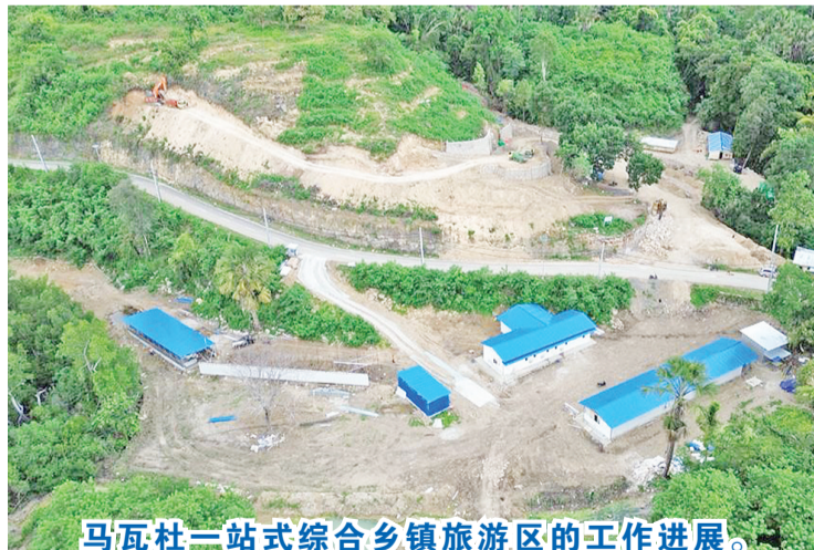
马瓦杜一站式综合乡镇旅游区的工作进展。
