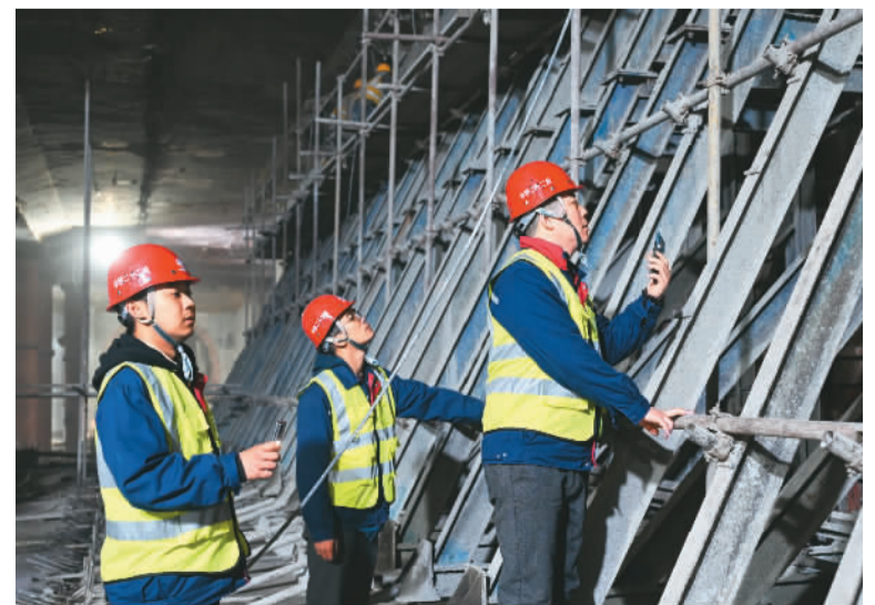
4月11日,由中铁二十二局承建的长春地铁6号线飞跃广场站、欧亚卖场站主体结构及两站区间工程完工,标志着工程建设取得阶段性进展。据介绍,长春地铁6号线全长29.57公里,共设车站22座,连接长春市西部新城、高新南区等重要功能区,建成通车后将进一步改善当地交通,助力优化城市空间布局。图为技术人员正在项目现场检查。宋强摄(人民视觉)
