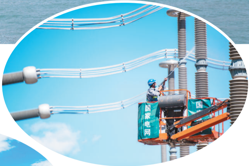
▲ 北京市延庆区八达岭镇里炮村，检修工人在张北柔性直流电网延庆换流站清洗绝缘立柱。
