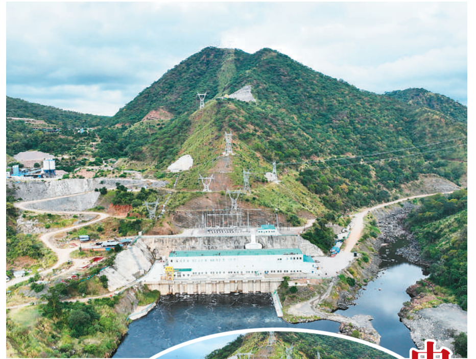
日前在赞比亚南方省航拍的下凯富峡水电站发电厂房。（新华社发）
