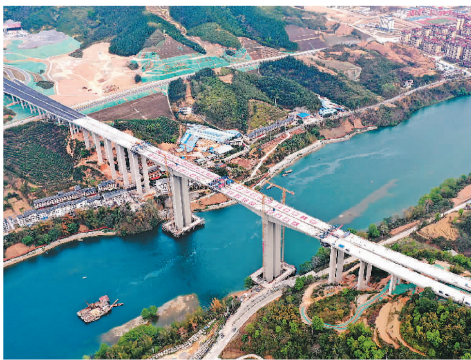
日前, 由广西交通投资集团投资建设、中交二航局承建的广西最大跨径六车道连续刚构桥——天峨至巴马高速公路(以下简称天巴高速)红水河特大桥实现双幅合龙。红水河特大桥是天巴高速项目的控制性工程, 位于广西河池市天峨县六排镇红水河上游, 全长1099米。图为天巴高速红水河特大桥建设现场。高东凤摄 (人民视觉)
