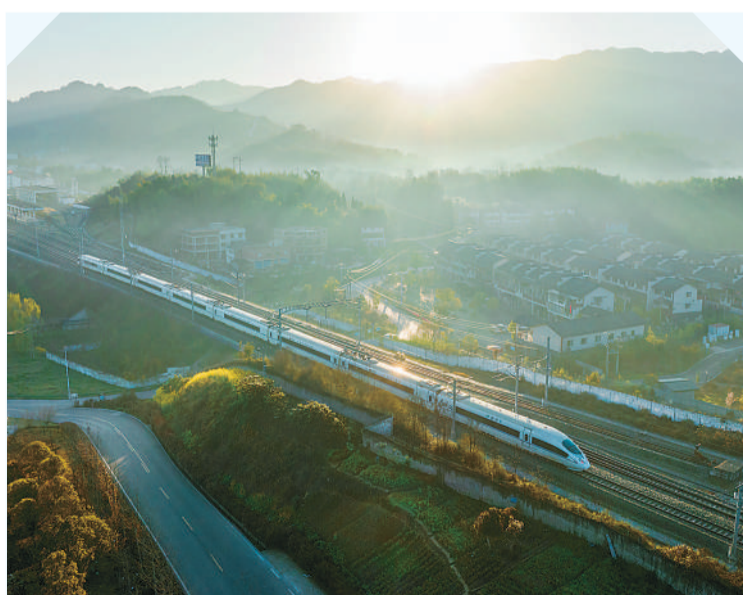
3月14日，列车行驶在郑渝高铁重庆市梁平区双桂街道安家村段。 高小华摄（人民视觉）
