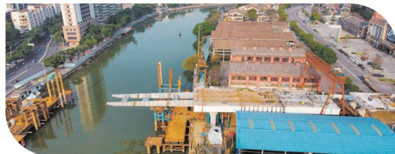
江門船廠跨江橋梁正進行主橋上部鋼箱梁及引橋現澆箱梁結構施工。
