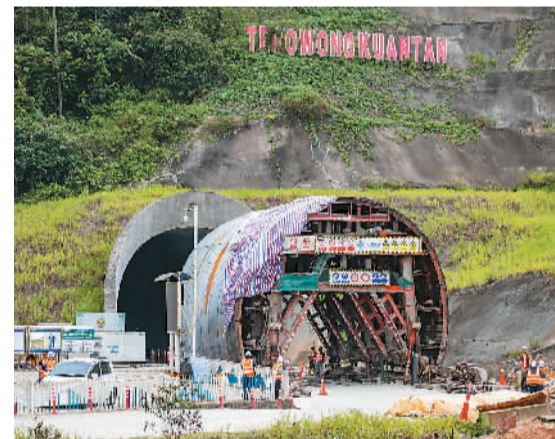
图为马来西亚东海岸铁路（马东铁）关丹隧道施工现场。张纹综摄（新华社发）
