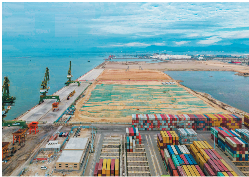
江阴港区6号和7号泊位项目现场。
