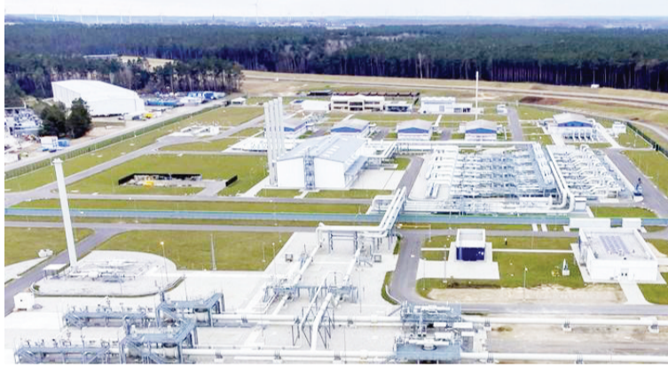
资料图：“北溪-2”天然气管道项目登陆设施的管道。
