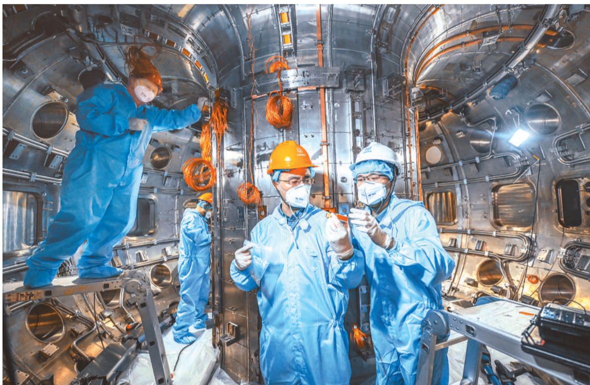
技术人员在新一代“人造太阳”真空室内解决技术难点。
