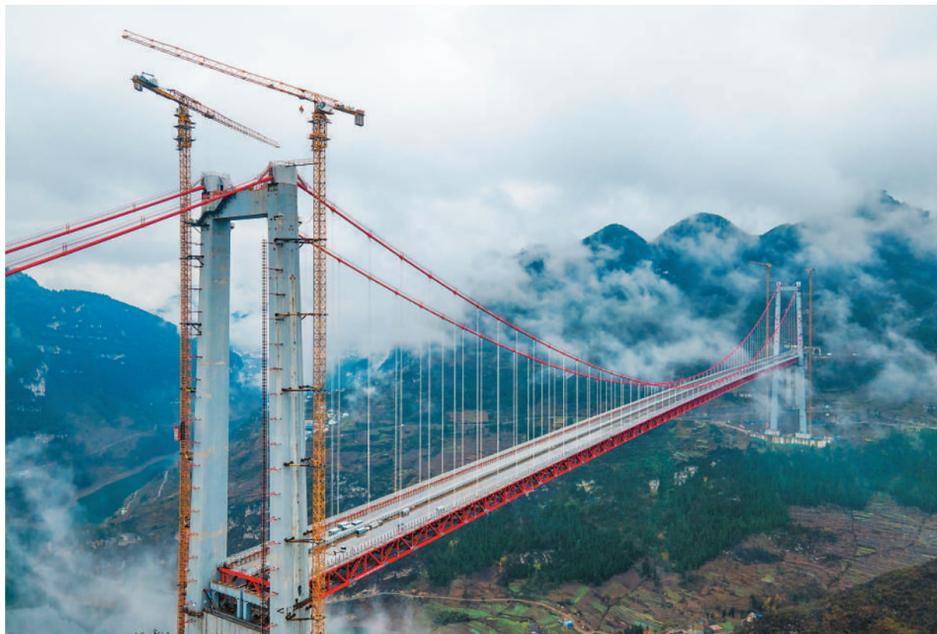
目前,位于贵州省遵义市仁怀市、桐梓县交界处的金仁桐高速桐梓河特大桥主体已基本建设完成,从远处看去犹如一条“钢铁巨龙”,蔚为壮观。大桥全长1422米、主跨965米,桥面距离河谷约365米,是全球首个高低塔采用无桩基础设计的大跨度悬索桥。
