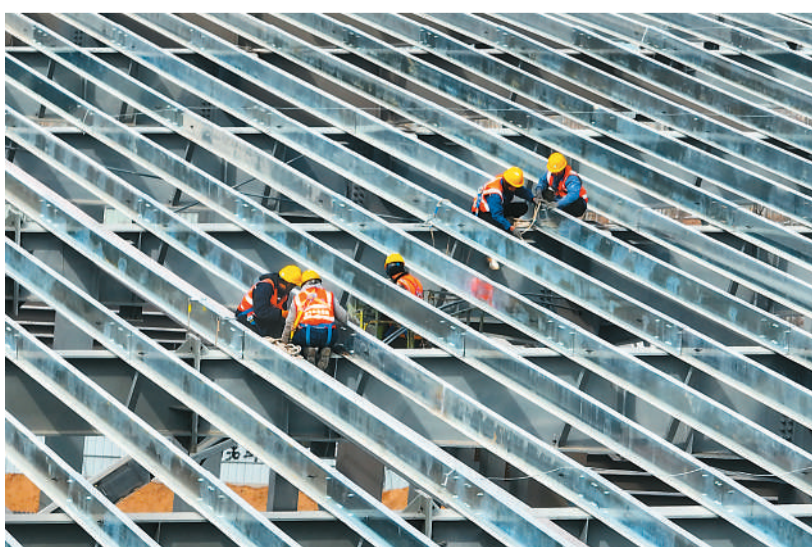
宁夏宝丰电池及储能集装系统示范项目是宁夏重点工程，包括中试车间、空压蒸汽站、电芯厂房、测试中心等。示范项目工程建成后将有力推动清洁能源、新材料重点产业发展。图为近日工人正在该项目建设工地组装厂房钢架。袁宏彦摄（人民视觉）
