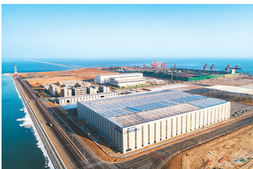
山东东营经济技术开发区依托港口及腹地土地储备优势，规划建设东营海上风电装备产业园。目前，已签约落地项目23个，总投资243亿元，海上风电装备产业链条逐步成型，产业集群初步成型。图正在建设中的东营海上风电装备产业园。杨胜男摄（人民视觉）
