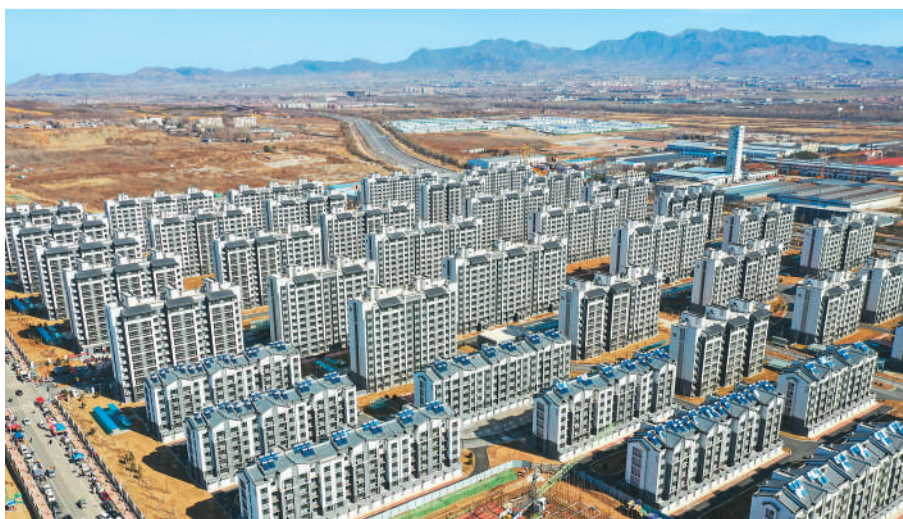
2月21日，山东省济南市章丘区重点民生工程山阳片区旧村改造项目首批3583户回迁居民喜搬安置房。山阳片区旧村改造项目由中铁建工集团有限公司承建，总建筑面积达108万平方米，可提供安置房9411套，项目将于2023年底全部交付使用。图为首批交付的安置房新居。新华社记者 朱 峰摄
