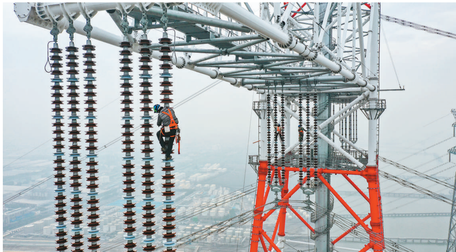
2月20日, 在385米世界最高输电铁塔——江苏凤城至梅里500千伏输电线路工程长江大跨越现场, 施工人员正在百米高空进行走线验收, 全面检查施工工艺, 确保工程以“零缺陷”的状态投运。该工程建成投运后, 可将长江北岸的新能源不断送往江南, 满足约800万户家庭的日常用电需求。史俊摄(人民图片)
