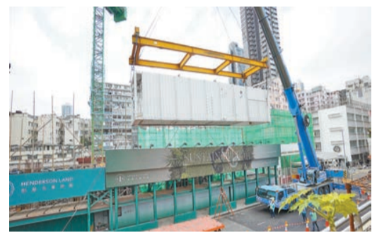
「南昌220」過渡房屋昨日拆卸，組件遷大埔黃魚灘重新裝嵌使用。記者 馮俊文攝
