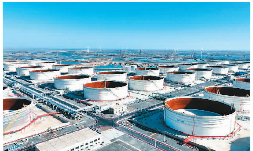
2月16日，我国一次性建设规模最大的原油商业储备库项目——东营原油商业储备库项目在山东省东营市东营港经济开发区投油成功，正式进入试生产和商业运营阶段。该项目由中国海油投资建设，共建设50座10万立方米原油储罐及配套设施，可储原油约425万吨，是我国首个实现数字化交付的大型原油储备库项目。项目投产后，预计每年新增东营港吞吐能力1500万吨，实现进出口贸易额200亿元。徐秋萍摄（人民视觉）
