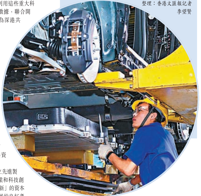
◆前在深圳比亞迪總部，工人為新能源汽車安裝電池。
