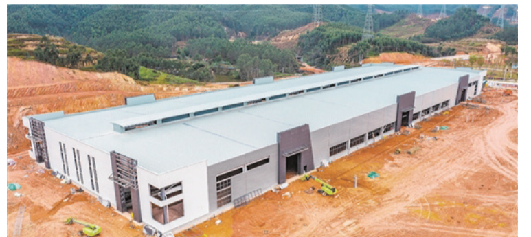
科達利新能源汽車動力電池精密結構件項目
