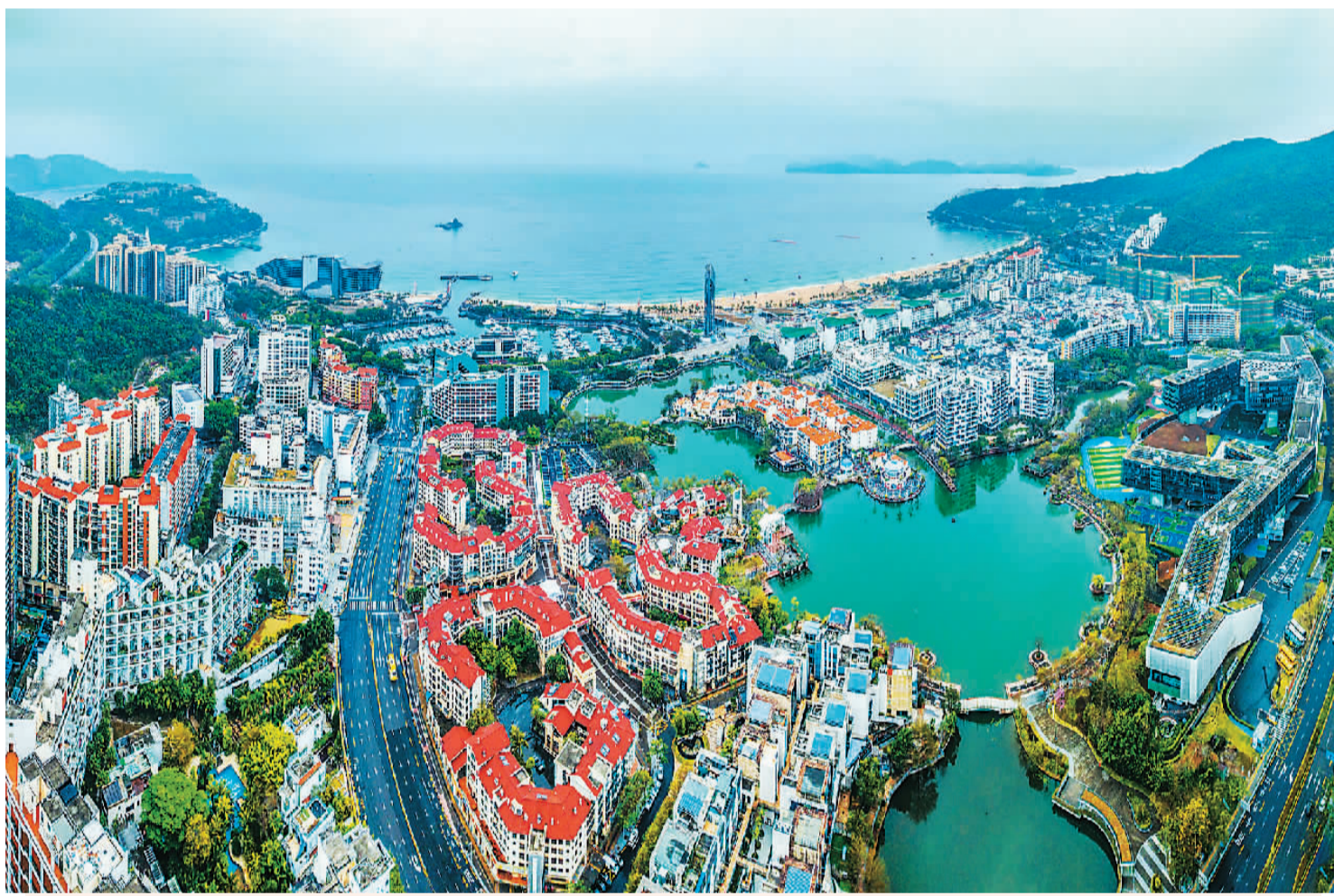
广东省深圳市盐田区梅沙街道近积极探索近零碳排放试点工作，广泛开展培植增绿和生态修复治理，充分利用生态化处理技术治污减排，消除餐厨垃圾和水污染，通过“生态屋顶”和提升“绿电”使用比例，达到微气候调节、雨水调蓄等，大大减少能耗，建设人与自然和谐共生的零碳样本。 胡学军摄（人民视觉）
