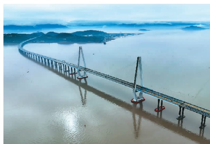
近年来，浙江省玉环市大力建设“五纵五连一环岛”路网，有力助推了农村产业结构调整，带动了乡村旅游发展和农产品的流通，为县域经济发展和乡村振兴提供了有力支撑。图为2月6日拍摄的玉环市乐清湾跨海大桥。段俊利摄（人民视觉）
