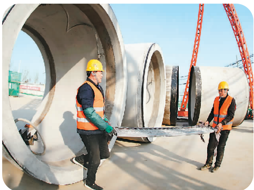
连日来，北京南水北调配套工程大兴支线机场连接线工地施工稳步推进。该机场连接线是南水北调中线进京第二通道大兴支线的组成部分。图为2月6日，工人在搬运建筑材料。新华社记者李欣摄
