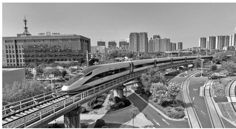
交通部确保雅-万高铁能够于2023年7月投入运营。到目前为止,雅万高铁工程在建设和其他方面都无
