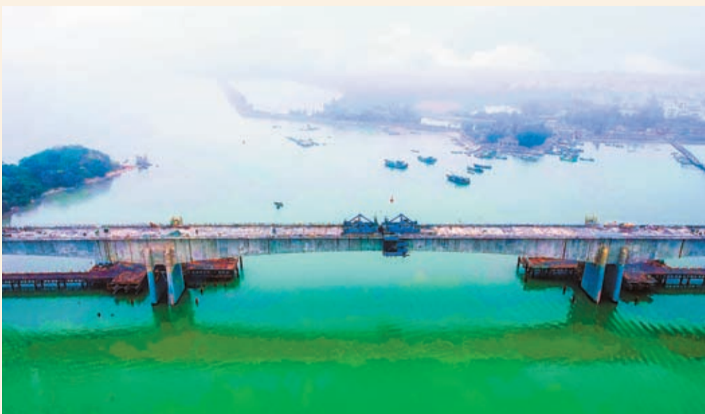
濠江特大橋跨濠江水道160米剛構連續梁順利實現合龍。陳史攝
