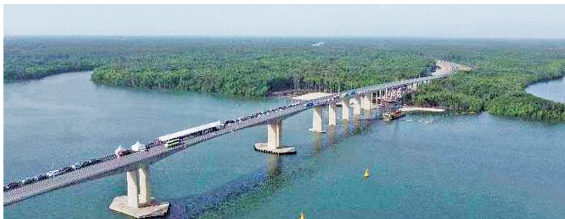
柔佛州蒲莱河大桥是柔佛州地区的重点经济民生项目。
