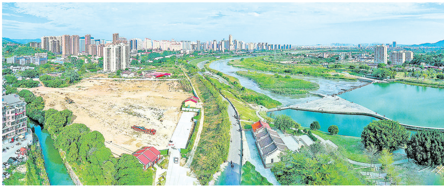
图为位于木兰陂一侧的福建省水利博物馆建设现场。全媒体记者 杨怡玲 摄
