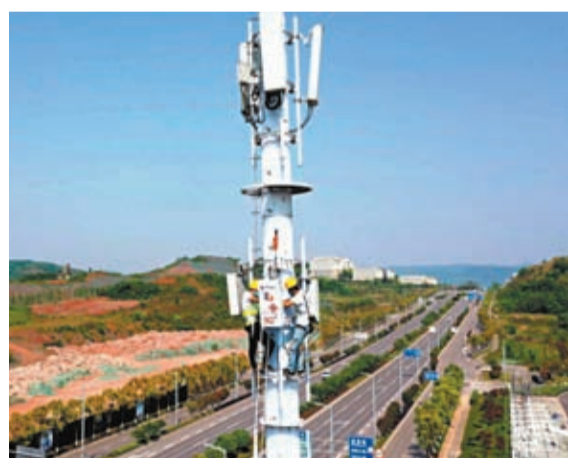
◆中國將啟動「寬帶邊疆」建設，全面推進6G技術研發，圖為工作人員在位於重慶高新區高新大道的5G基站建設現場作業。資料圖片
