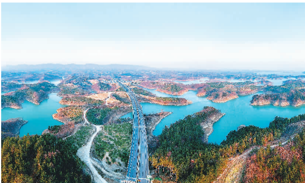
1月6日, 由湖北交投投资建设、中交二航局承建的世界最大跨径部分地锚式混合梁斜拉桥——十堰至浙川高速公路丹江口水库特大桥建成通车, 标志着十浙高速公路(湖北段)正式通车。作为纵贯南北的鄂豫省际快速通道, 十浙高速建成通车后, 将实现鄂西北到豫西南1小时快速直达, 比原行车时间节约近2小时。
