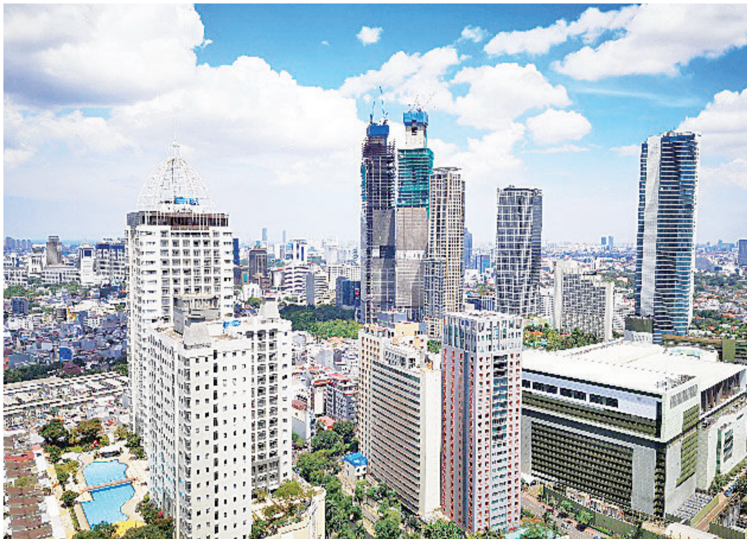
由中企承建的雅加达“双子塔”，因新冠疫情暂停两年多，已复工建设。
