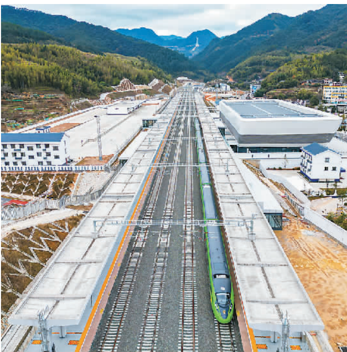
兴泉铁路(江西兴国—福建泉州)清流至泉州段近日建成开通。至此，兴泉铁路实现全线贯通运营，海峡两岸铁路运输能力极大提升，赣南和闽西革命老区经济社会发展步入“快车道”。该铁路于2017年开工建设，全长464公里，设计时速160公里。
