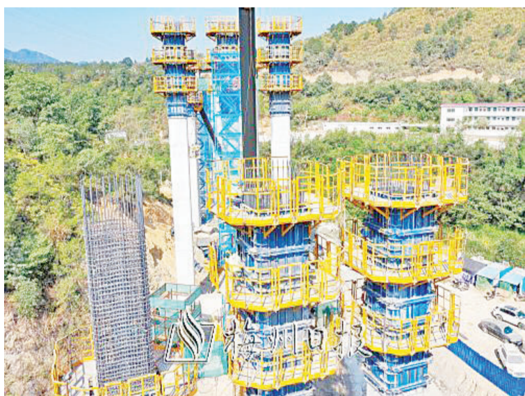
西部旅游快线建设现场。(高讯摄)
