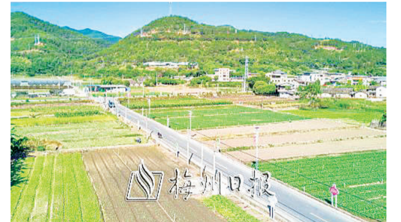
提升改造后的乡道170铺上了沥青。(林翔摄)
